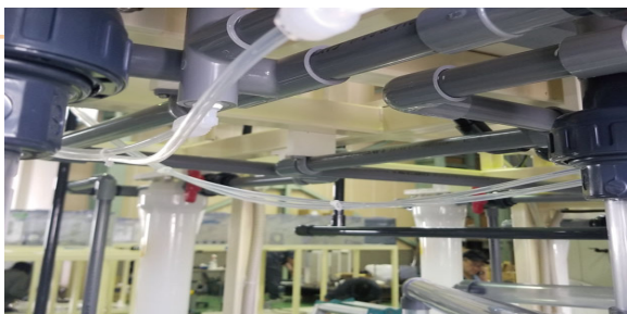
P16A-PT1/4ブッシング施工事例
